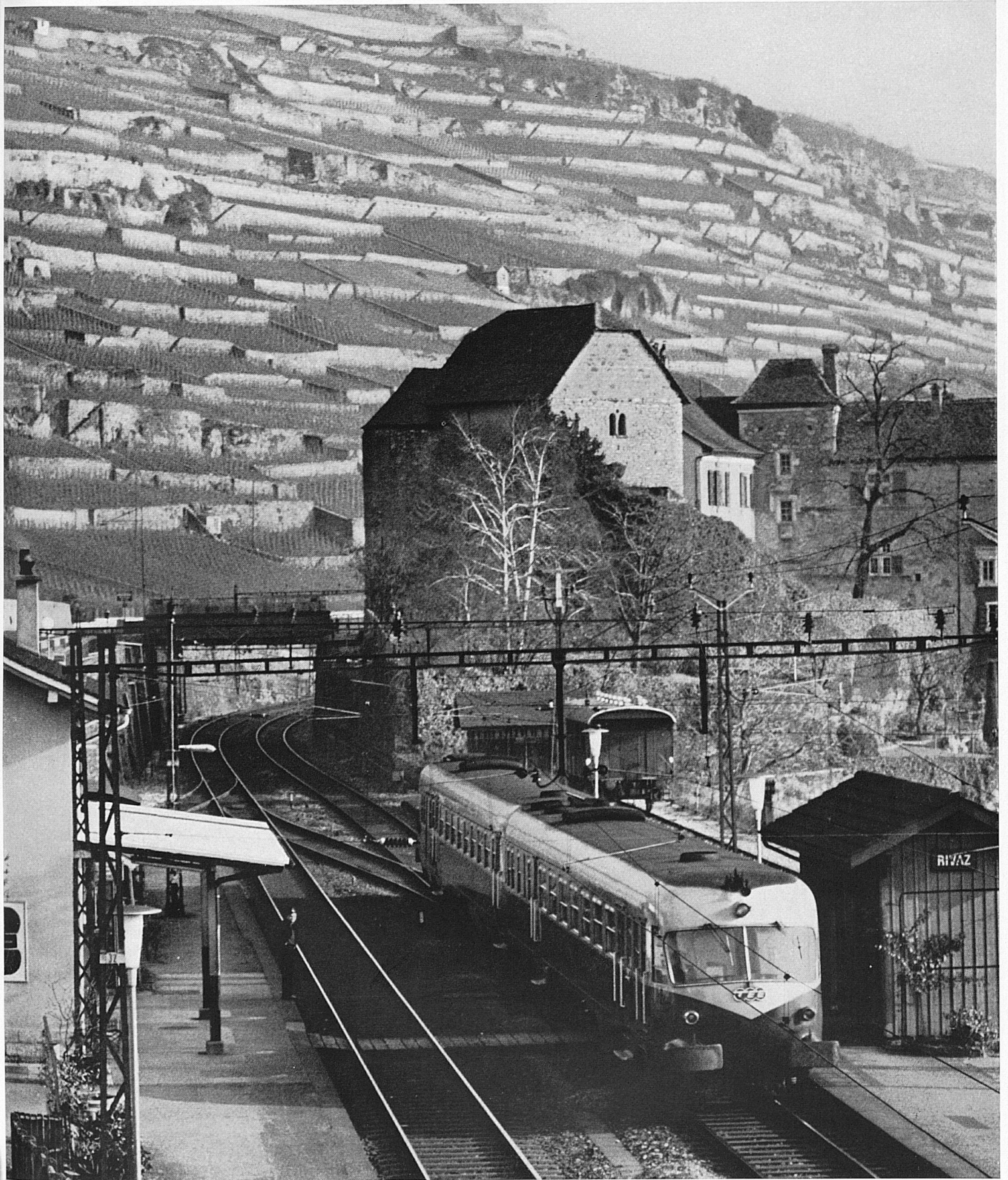
Un treno Transeuropa-Espresso - TEE - dal Sempione reca il viaggiatore, attraverso il paesaggio dai terrazzi popolati di viti di Lavaux, alla città dell'Esposizione nazionale, Losanna. Nel mezzo dell'immagine, il castello medievale di Glérolles, sede un tempo del vescovo di Losanna.
