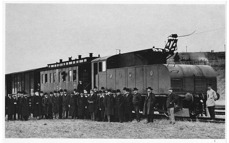
1 Der Versuchszug Seebach-Wettingen mit Lokomotive Nr. 1 (1904, 40 t, 500 PS, 60 km/h). Eine Aufnahme vom 12. März 1904. Unter den Gästen der Probefahrt erkennen wir Ingenieur Dr. h. c. Emil Huber-Stockar, 1865–1939, Direktor der Maschinenfabrik Oerlikon und später Leiter der SBB-Elektrifikation (†). Er war der Schöpfer des elektrischen Vollbahnbetriebes mit hochgespanntem Einphasen-Wechselstrom niedriger Frequenz.
