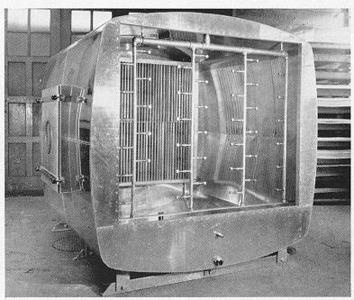
Luftwäscher und Befeuchter aus Aluminium geschweißt
