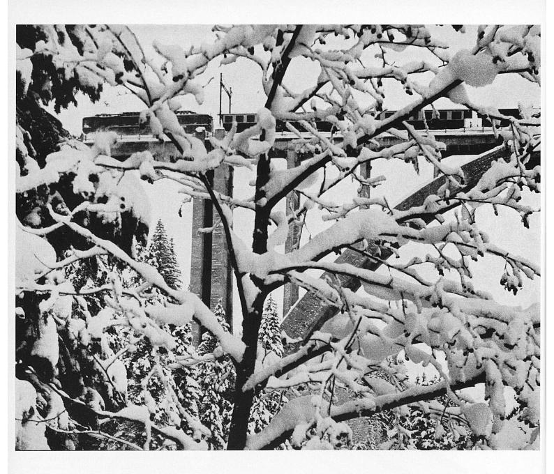
1520 m ü.M. fährt die Rhätische Bahn auf dem Weg von Chur nach Arosa über den 287 m langen und 62 m hohen Langwieser Viadukt, die 1914 errichtete erste Brücke aus armiertem Beton in der Schweiz. Mehr als 480 Brücken waren zum Bau des Gesamtnetzes der Rhätischen Bahn erforderlich, deren grosse Bedeutung für Graubünden der Reisende vor allem im Winter eindrücklich ermisst, wenn er durch eine tiefverschneite Bergwelt seinem Ferienziel zustrebt. Photo Giegel SVZ
