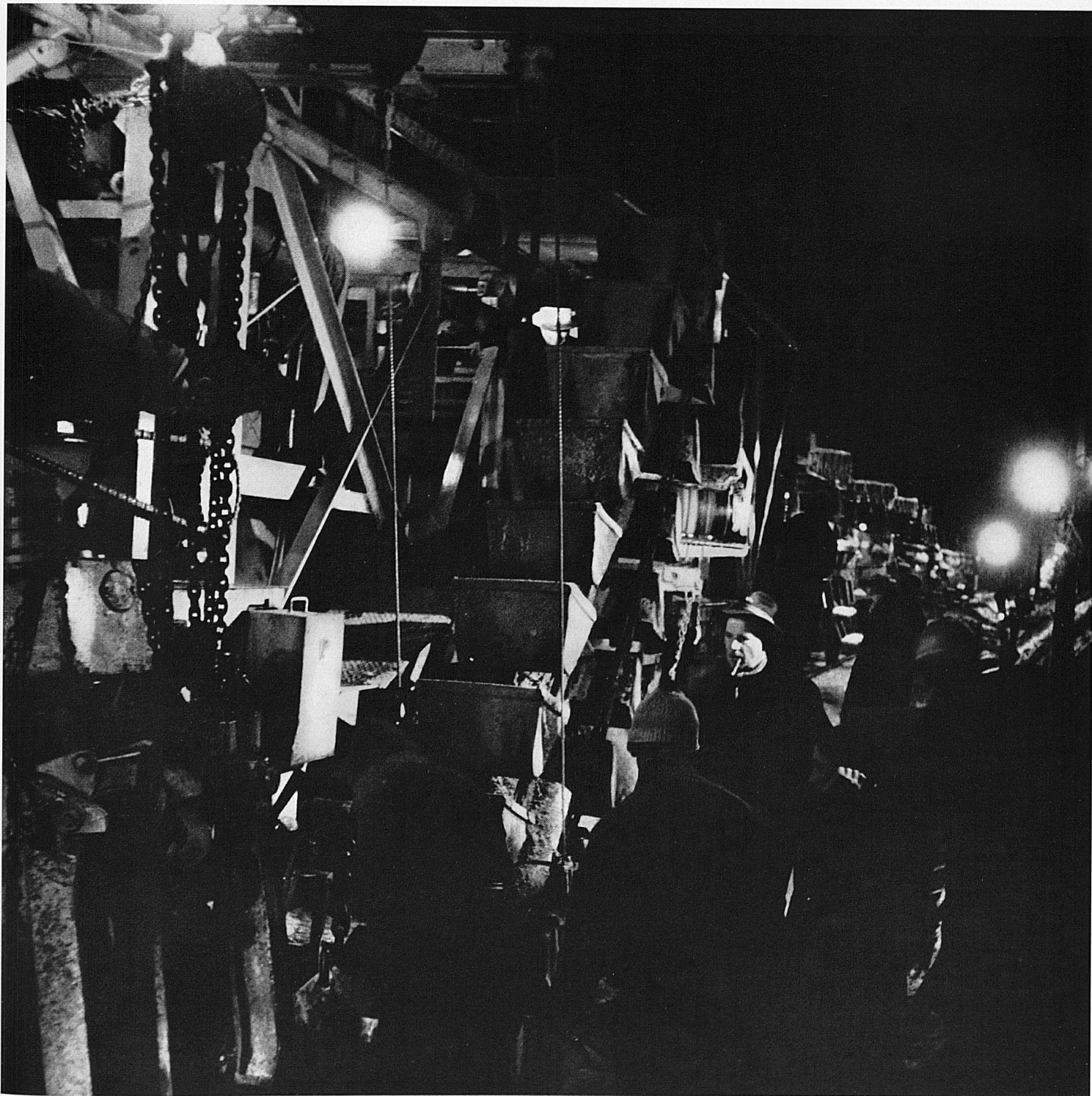
Die Schotterreinigungsmaschine im Betrieb. Photos Fred Mayer La criblouse en plein travail La vagliatrice della ghiaia durante il lavoro. The ballast cleaning machine in operation.
