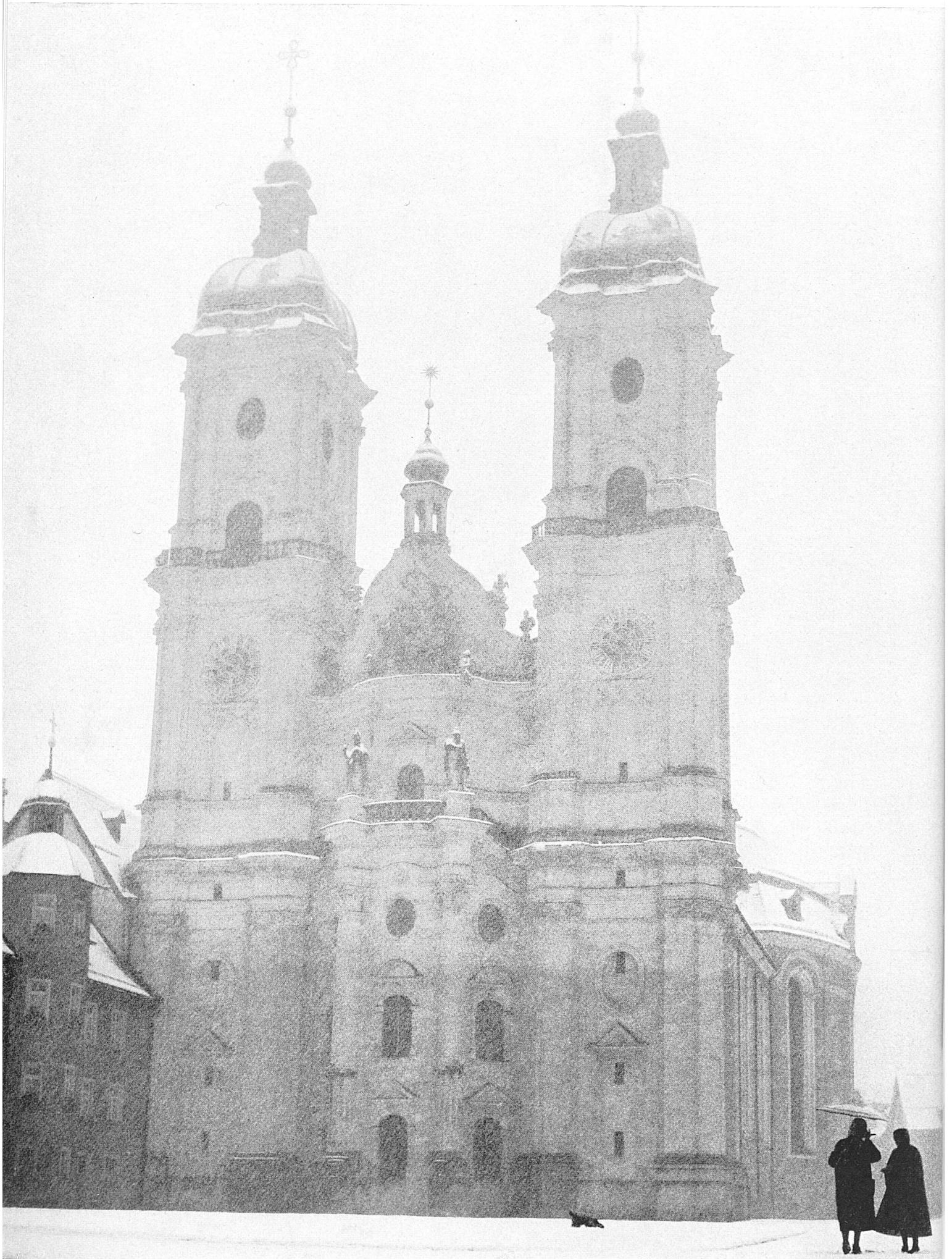
La cattedrale di San Gallo, pregevole edificio barocco.
