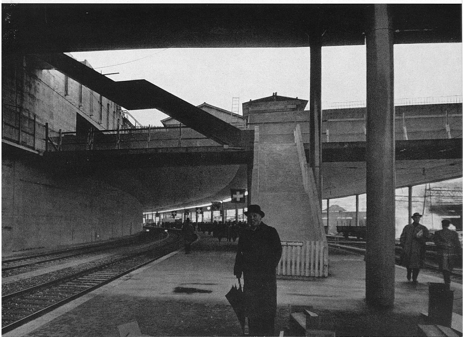
partie excavée des Grands-Remparts. Cet endroit de la nouvelle gare est déjà recouvert d'une dalle, sur laquelle trouveront place le garage dit du «Parc» et une partie du bâtiment de la poste.
