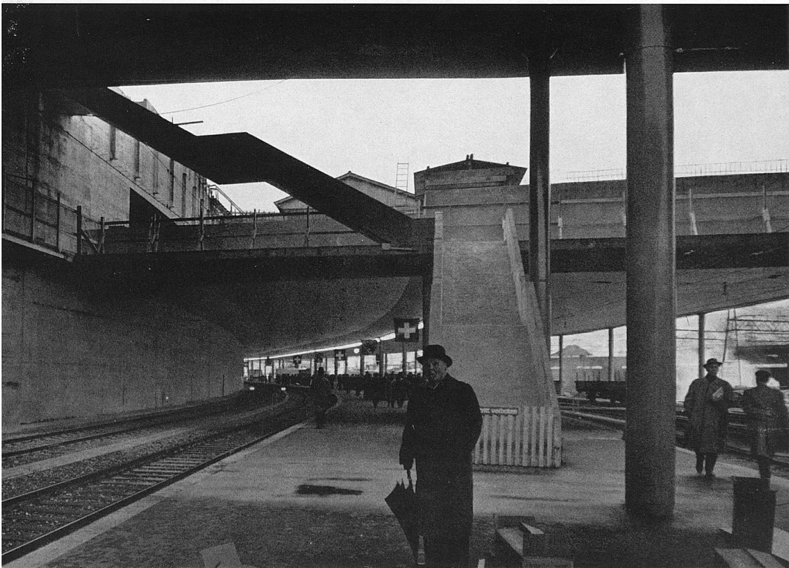
partie excavée des Grands-Remparts. Cet endroit de la nouvelle gare est déjà recouvert d'une dalle, sur laquelle trouveront place le garage dit du «Parc» et une partie du bâtiment de la poste.
