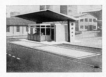
Automatische Verbund-Brückenwaage für Straßenfahrzeuge. Wägefähigkeit 30 t. Es kann mit jeder Brücke einzeln oder mit beiden zusammen gewogen werden. Kranwaage. Wägefähigkeit 50 000 kg, Eigengewicht zirka 3000 kg, totale Höhe zirka 3,3 m. Mit dieser Kranwaage, die eine Ablesegenauigkeit von 1 kg besitzt, kann der Wiegevorgang, insbesondere in Betrieben mit großen Stückgewichten, vereinfacht und rationalisiert werden.
