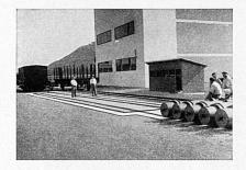
Brückenwaage für Geleisefahrzeuge. Wägefähigkeit 200 000 kg, Brückenlänge 24 m, Brücke in vorgespanntem Beton mit nur 4 Auflagern. Anläßlich der amtlichen Eichung ergab sich ein maximaler Fehler in der Gewichtsanzeige von nur 1-9 kg. Die Empfindlichkeit bei Vollast betrug 2 kg.
