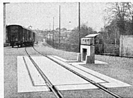
Brückenwaage für Geleise- und Straßenfahrzeuge. Wägefähigkeit 70 000 kg
