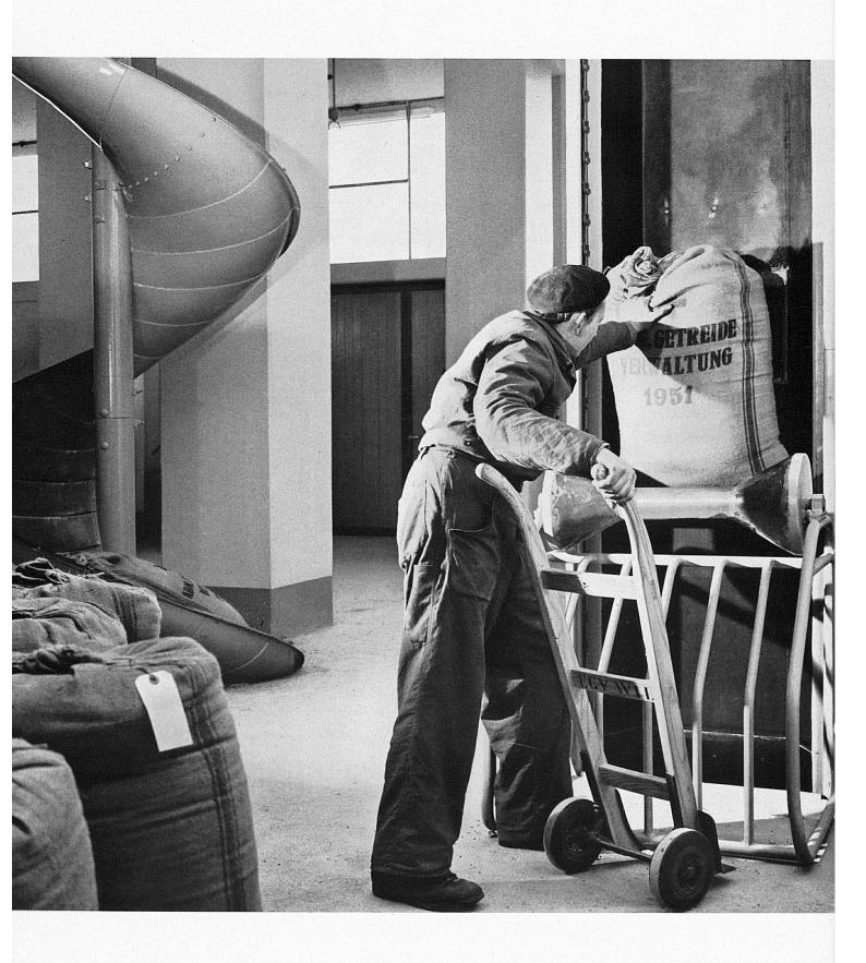
Sackwendelrutsche und Sackaufzug im Getreidesilo Wil der Schweizerischen Bundesbahnen Glissoir et treuil à sacs du silo à grain des Chemins de fer fédéraux à Wil Wil: arganello e scivola-sacchi nel silo di proprietà delle Ferrovie federali svizzere Spiral sack chute and sack hoist in the Swiss Federal Railways grain elevator at Wil
