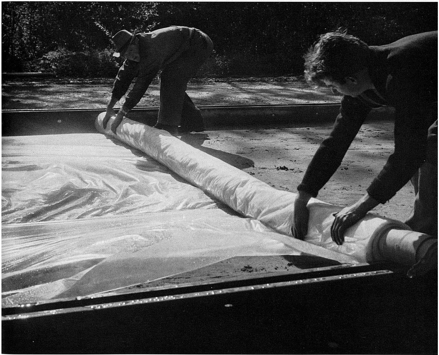
Die Schweiz gehört auf dem Gebiet des Betonstraßenbaues zu den führenden Ländern, da ein Studienbüro seit mehr als 30 Jahren Erfahrungen sammelt und verbesserte Arbeitsverfahren entwickelt. So sichert zum Beispiel eine Plastikfolie, auf der Unterlage ausgebreitet, den richtigen Wassergehalt des Betons bis zum Abbinden (Erhärteten). Photos F. Raußer
