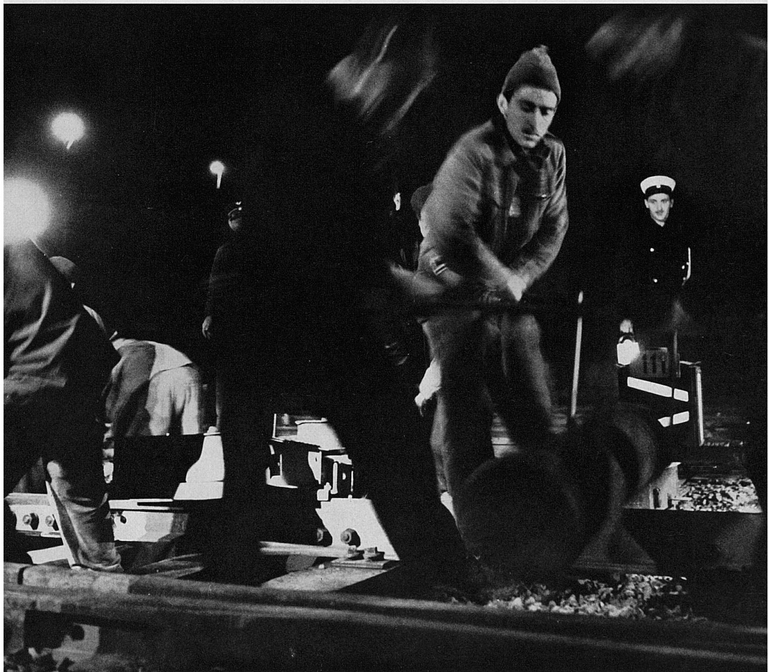
Nach der Entfernung der alten Weicheneinheiten werden die neuen Weichenteile mit den Kranen präzis an die vorausberechneten Stellen verlegt (Bild rechts). Für die letzten Finessen aber (Bild oben) ist wiederum die manuelle Arbeit der Bahndiensttrotten unerlässlich.
