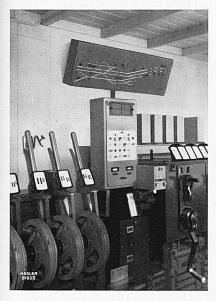
Stationsausrüstung für einen automatischen Block mit fernbedienter Blockstelle, angebaut an ein mechanisches Stellwerk. Rechts die Hebelsperren und in der Mitte der Bedienungsapparat. vertraut vorbehaltlos auf die Betriebssicherheit der schweizerischen Eisenbahnen. Und dies mit vollem Recht, denn die Eisenbahntechnik ist heute so hochentwickelt, daß auch menschliche Unzulänglichkeiten weitgehend ausgeschaltet werden können.
