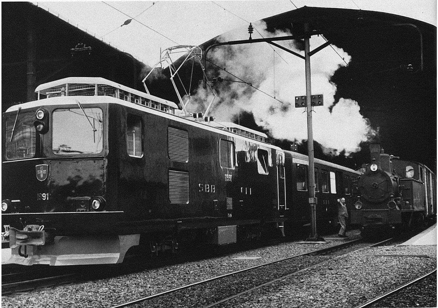
Mit dem Sommerfahrplan wurde auf der Brünigstrecke der Schweizerischen Bundesbahnen die elektrische Zahnrad- und Adhäsionslokomotive HG 4/4 eingesetzt. Mit einer Stundenleistung von 2300 PS ist sie die leistungsfähigste bisher gebaute Zahnrad- und Schmalspurlokomotive. Hier steht sie im Bahnhof Luzern, begrüßt vom Dampf einer alten Kollegin.
