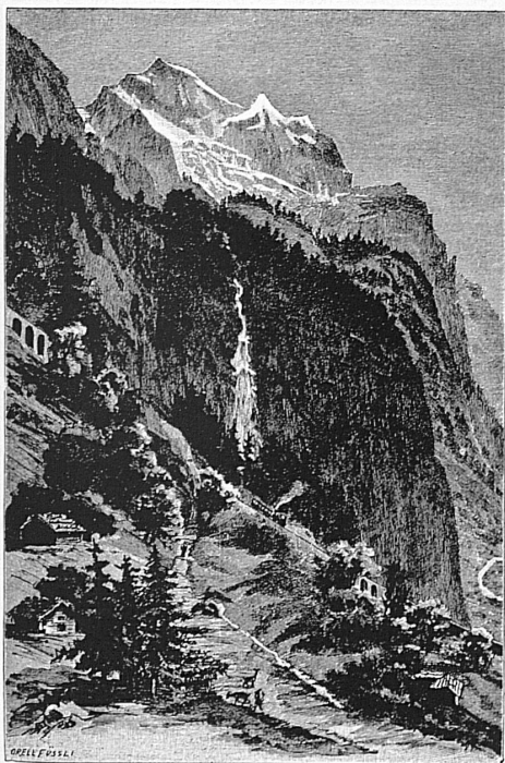
Die alte Wengernalp-Bahnlinie über Lauterbrunnen L'ancienne ligne du chemin de fer de la Wengernalp au-dessus de Lauterbrunnen
