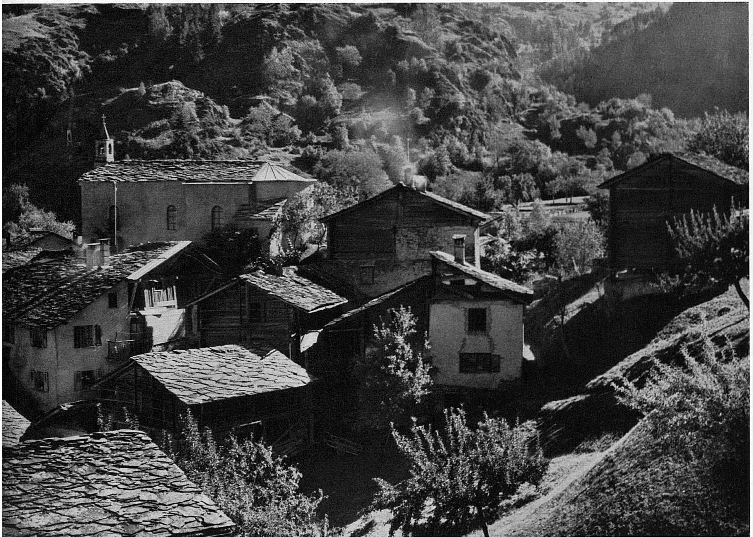
Oben: Ein Weiler im Val de Bagnes. Rechts im Bild ein typischer auf Pfosten ruhender Walliser Speicher. Die Sockel sind von runden Steinplatten bedeckt, um den Nagern den Zutritt zu den Vorräten zu verwehren. Photo Rast, Freiburg.
