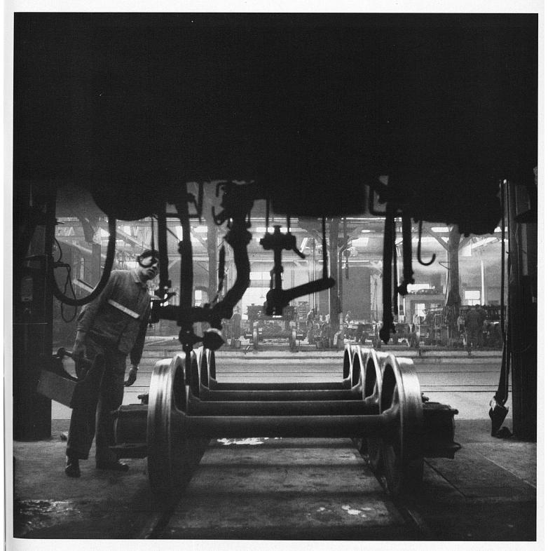
Die aufgearbeiteten Radsätze stehen für den Einbau unter den Wagen bereit. – Réparés, les essieux montés sont prêts à être fixés aux wagons. – La coppia di ruote rifinite è Pronta per essere applicata alla carrozza. – The processed wheels are ready to be mounted beneath the carriages. – Los pares de ruedas se hallan preparados para ser montados bajo los vagones.
