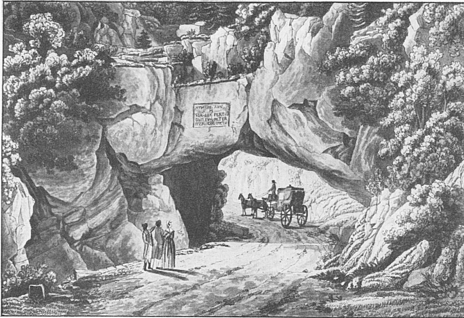
Römischer Straßendurchbruch der Pierre Pertuis bei Tavannes. Aquatinta von P. Biermann, 1758–1844 Passage romain de Pierre Pertuis, près de Tavannes. Gravure de P. Biermann, 1758–1844 Passaggio romano di Pierre Pertuis, presso Tavannes. Acquatinta di P. Biermann, 1758–1844
