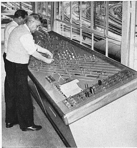
Le pupitre de commande du poste 1 qui reproduit le schéma des voies. L'aiguilleur «voit» toutes les manœuvres s'exécuter sur son pupitre. – Das Kommandopult des Postens I mit der Darstellung des Geleisefeldes, welche jedes Rangiermanöver genau sich abzeichneten läßt.
