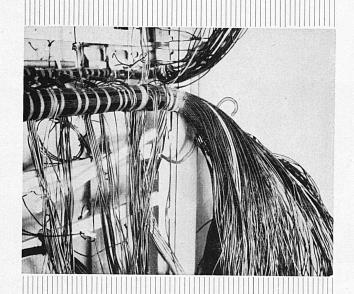
Bild vom Bau einer Signalanlage der SBB Bündel von Soflex-Drähten in einem noch ungeschalteten Relaisgestell
