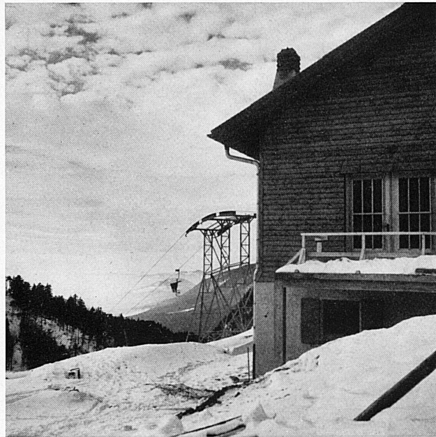
Oben: Die Zwischenstation «Nesselboden» liegt in flacher Senke zwischen dem die Talstation Oberdorf überragenden, stotzigen Malmkalkgrat und dem eigentlichen Weissensteintrücken. Ci-dessus: La station intermédiaire de Nesselboden. Photo: Heri
