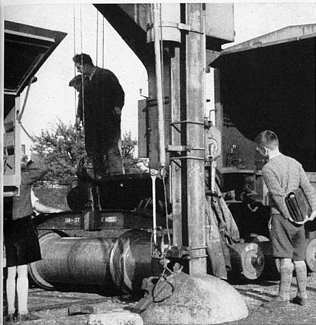
← Links: Die tonnenschweren Eichgewichte, die im Innern des Wagenkastens untergebracht sind, können mit dem auf dem Eichwagen aufgebauten Kran mühelos bewegt werden.
