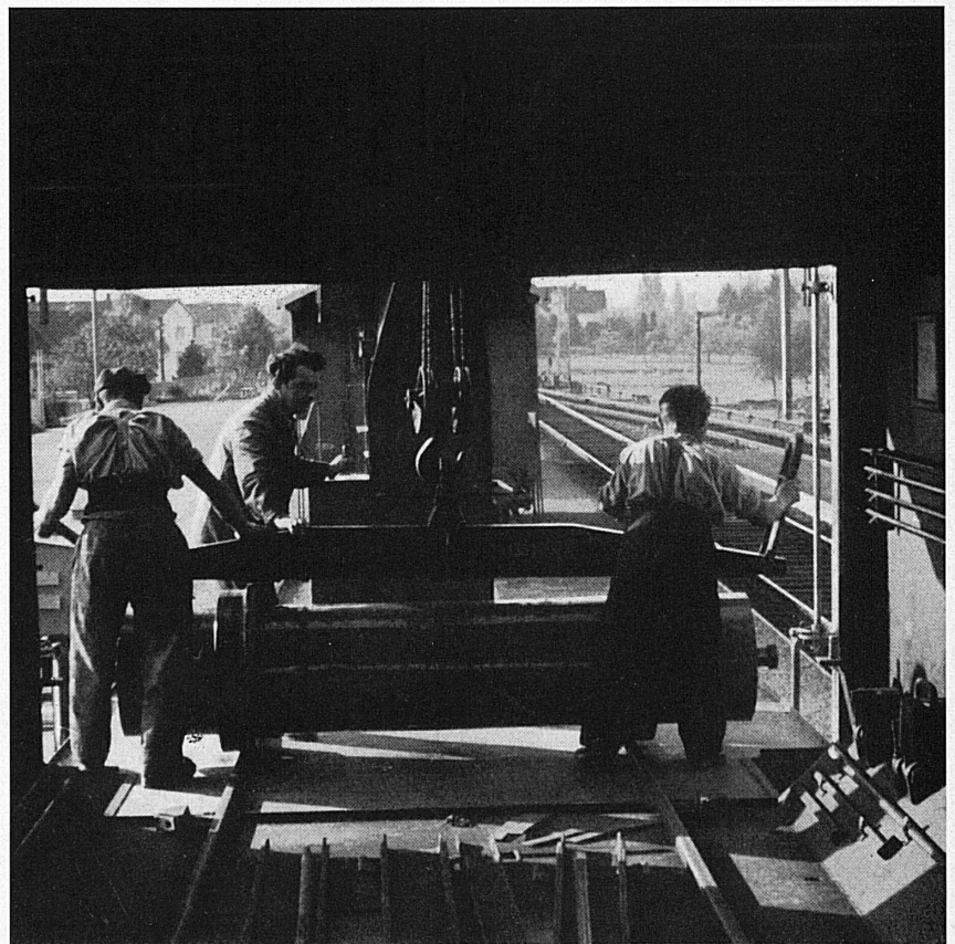
↓ Ci-dessous: Le wagon-étalon est un atelier; les poids cylindriques sont pourvus de bandages ordinaires de roues permettant de les rouler sur rails jusque sur la plate-forme de la grue.
