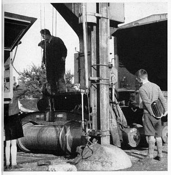
Links: Die tonnenschweren Eichgewichte, die im Innern des Wagenkastens untergebracht sind, können mit dem auf dem Eichwagen aufgebauten Kran mühelos bewegt werden.
