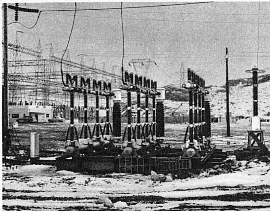
Der abgebildete 220-kV-Druckluftschnellschalter war in dieser bekannten Anlage der Bonneville Power Administration in den USA, wo schon wiederholt Schaltversuche durchgeführt wurden, eingesetzt, weil sonst nirgends in der Welt Kurzschlüsse mit einer derart großen Leistungskonzentration erzeugt werden können. 13 Generatoren von je 108 000 kVA und acht 230-kV-Leitungen speisten die Kurzschlußstelle.
