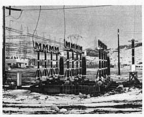
Der abgebildete 220-kV-Druckluftschneilschalter war in dieser bekannten Anlage der Bonneville Power Administration in den USA, wo schon wiederholt Schaltversuche durchgeführt wurden, eingesetzt, weil sonst nirgends in der Welt Kurzschlüsse mit einer derart großen Leistungskonzentration erzeugt werden können. 13 Generatoren von je 108 000 kVA und acht 230-kV-Leitungen speisten die Kurzschlußstelle.
