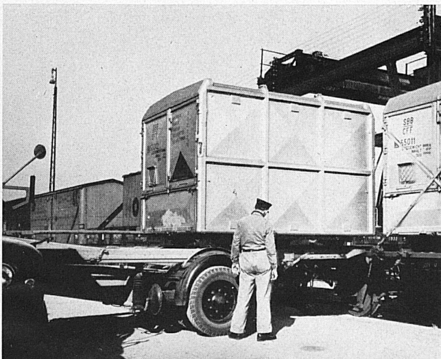
Links: Ein geschlossener Behälter wird vom Bahnwagen auf den Camion verladen. A gauche: On transporte un container fermé d'un wagon sur un camion.
