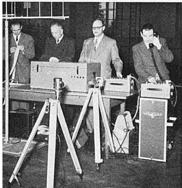
Oben: Ein neues Zeitmeßgerät für sportliche Veranstaltungen, die so genannte «Chronocamera», wurde von der Longines-Uhrenfabrik auf den Markt gebracht und dürfte schon diesen Winter wertvolle Dienste leisten. Es ermöglicht u. a. die drahtlose Übermittlung des Startzeichens und die automatische Registrierung des Resultats auf einem Filmsstreifen bei einer Genauigkeit von  $\frac{1}{100}$  Sekunde.
