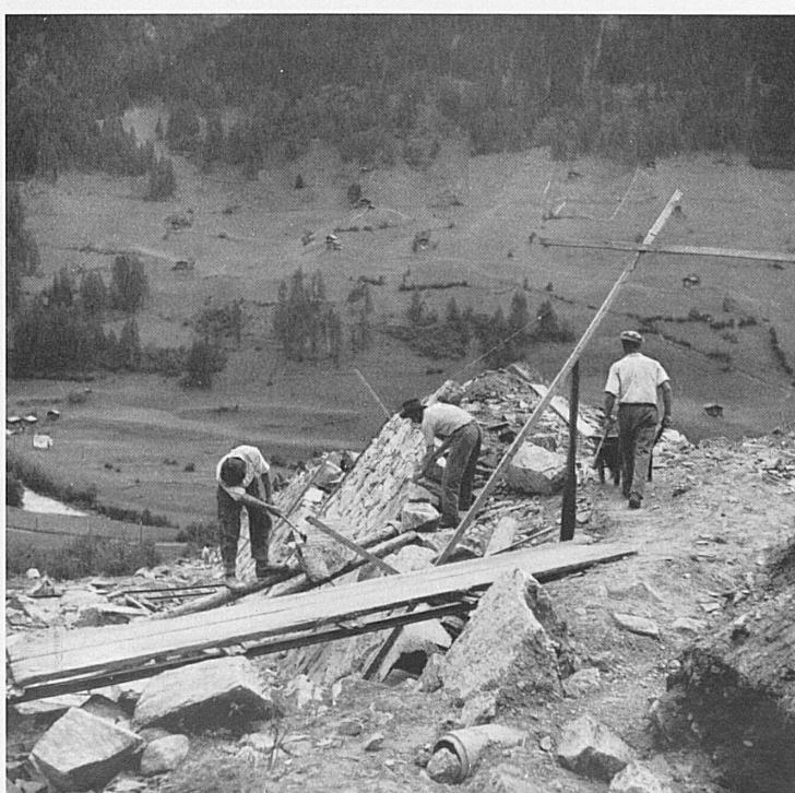
Links: Die Schutzwehr wird an einen naturgeschaffenen Geländeabsatz angeschlossen, um fürderhin der Lawi jede Durchbruchsmöglichkeit zu nehmen. — A gauche: Pour barrer à l'avenir toute issue à l'avalanche, cette construction s'appuie à un remblai naturel.
