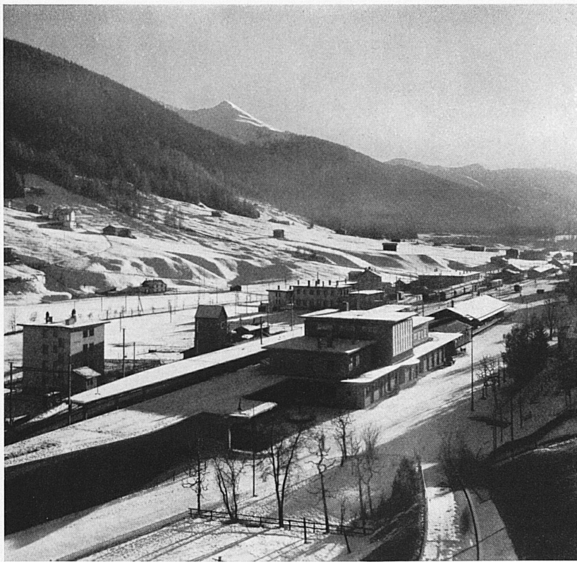
Oben: Die neue Bahnhofanlage von Davos-Platz ersetzt den Bau von 1922 (rechts). — Ci-dessus: La nouvelle gare de Davos-Platz. — Above: Railway station at Davos-Platz after the alterations made in 1947-1949. Photo: Meerkämper.
