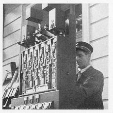
Links: Stellwerkmon-teur Kramer revidiert als allezeit gern gese-hener Gast in der Sta-tion den elektrischen Streckenblockapparat, auf dem die Sicher-heit des Bahnverkehrs zum guten Teil ruht. A gauche: Höte tou-jours bienvenu dans la petite gare, le monteur d'enclenchement Kramer revise l'appa-reillage électrique du bloc de ligne, duquel dépend en bonne par-tie la sécurité du tra-
