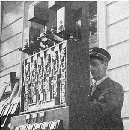
Links: Stellwerkmonteur Kramer revidiert als allezeit gern gesehener Gast in der Station den elektrischen Streckenblockapparat, auf dem die Sicherheit des Bahnverkehrs zum guten Teil ruht. A gauche: Hôte toujours bienvenu dans la petite gare, le monteur d'enclenchement Kramer revise l'appareillage électrique du bloc de ligne, duquel dépend en bonne partie la sécurité du trafic.
