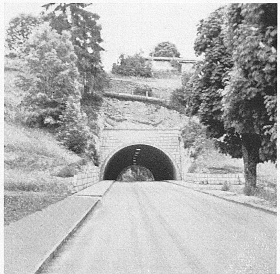
Straßentunnel in Les Brenets
