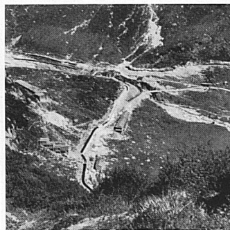
Oben: Die Baustelle auf der Alp Emaney. Nach links leitet der Stollen zum Barberine-See. – Ci-dessus: Le chantier de l'Alpe Emaney.
