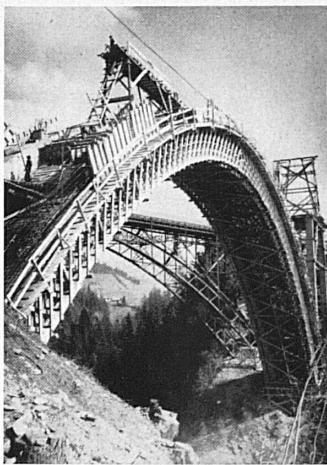
Oben: Eine neue Betonbrücke, deren eleganter Bogen 160 m Spannweite besitzt, ist bei Charney im Greyerzland im Bau begriffen. — Ci-dessus: On a commencé à Charney, en Gruyère, la construction d'un pont de béton dont l'arc élégant franchira à 160 m. le lit du Javroz.
