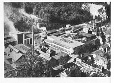
Oben: In das enge Tal hinein wurden die Fabrikhallen gebaut. Links im Bilde das Gebäude des Hochofens. — Ci-dessus: C'est dans cette vallée encaissée qu'ont été construites les halles de l'usine. A gauche, le bâtiment qui abrite le haut-fourneau.
