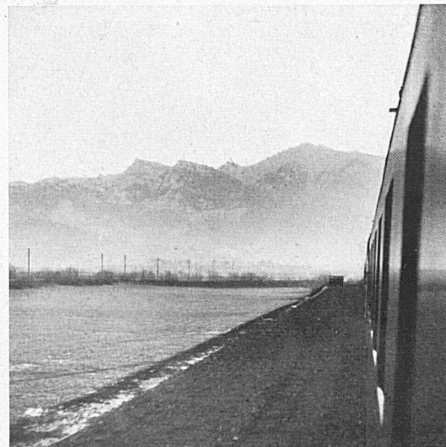
Oben: Der für die Aufnahme des zweiten Geleises vorbereitete Unterbau zwischen Reichenburg und Biltlen. — Ci-dessus: Le terrassement de la seconde voie est terminé sur le parcours entre Reichenburg et Biltlen.
