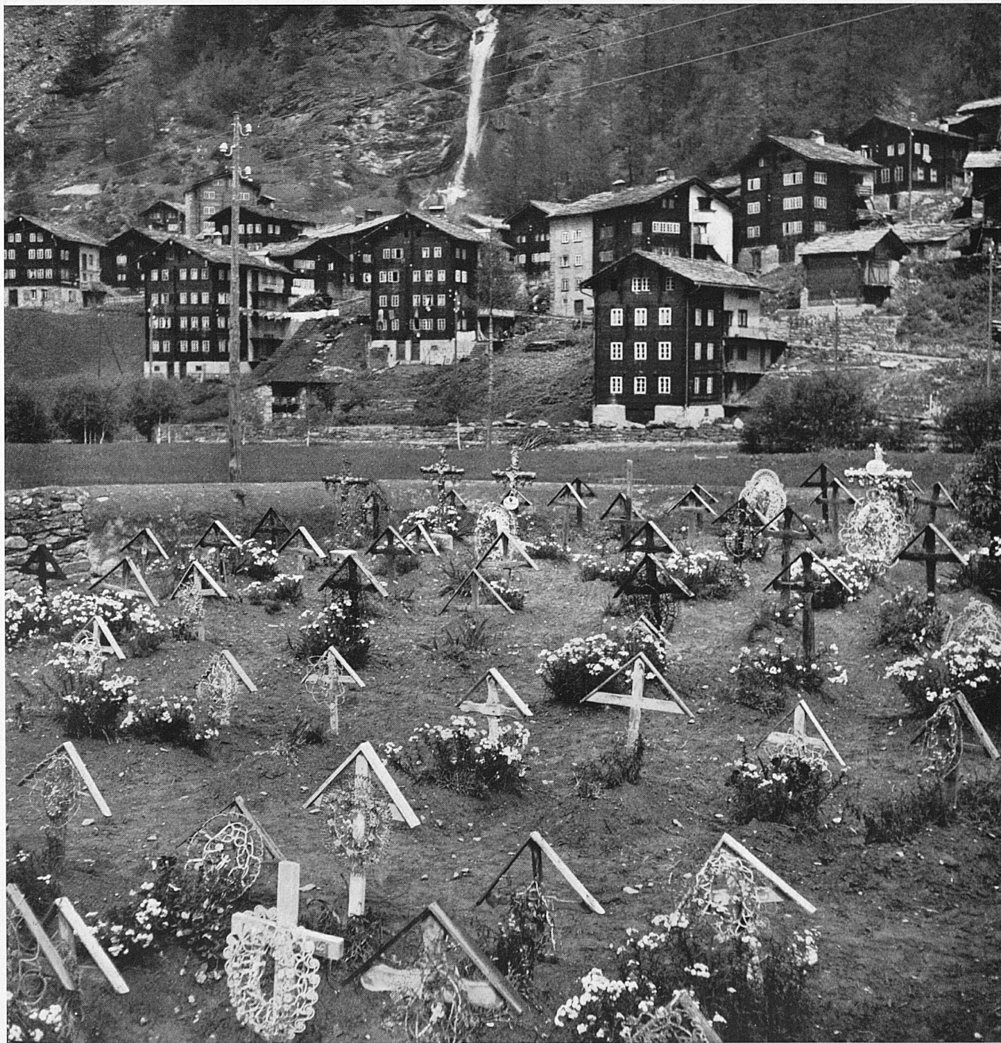
En haut: Maisons de Saas-Balen (Valais) en forme de tour, mi-bois mi-pierre. — Oben: Mehrstöckige, turmartige Wohnhäuser in Saas-Balen mit gemauertem Küchen- teil und Steinplattendächern. Photo: Heiniger.
