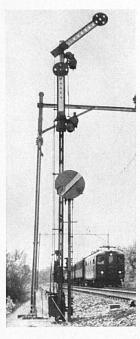
Einfahrsignal (Hauptsignal) mit Durchfahrsignal (Vorsignal) als mechanische Signale.
