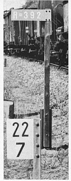
Der Radienzeiger (obere Tafel), der den Radius der betreffenden Kurve in Metern, sowie die Hektometertafel (im Bild unten), die die Distanz von der Ausgangsstation der betreffenden Linie angibt, sind für Bahnbau und -betrieb wertvolle Merkmale.
