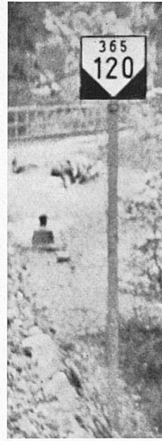
Der Neigungszeiger orientiert das Bahnpersonal über die Neignungsverhältnisse der betreffenden Strecke. Die größere Ziffer gibt die Neigung in ‰, die kleinere die Distanz in Metern bis zum nächsten Neignungswechsel an. Auf einer Tafel werden Steigungen durch einen nach oben gerichteten, Neigungen durch einen nach unten gerichteten weißen Pfeil auf schwarzem Grund angezeigt. Für horizontale Strecken zeigt die Tafel eine waagrecht unterteilte weiß-schwarze Fläche.
