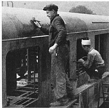
Lavage d'un wagon sortant de fabrication, séchage à l'air comprimé et peinture, ces opérations se suivent à un rythme rapide.
