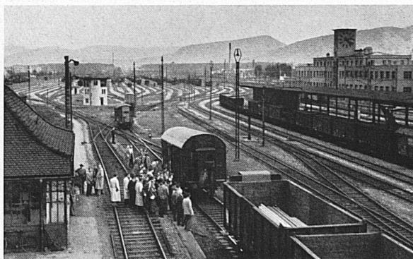
Groupés sur le dos d'âne de la grande gare de triage de Muttens, où un wagon vient de se détacher, les étudiants suivent les opérations avec un intérêt qui n'est pas feint. Au fond à gauche, le pavillon blanc pour le débranchement et le freinage hydraulique.
