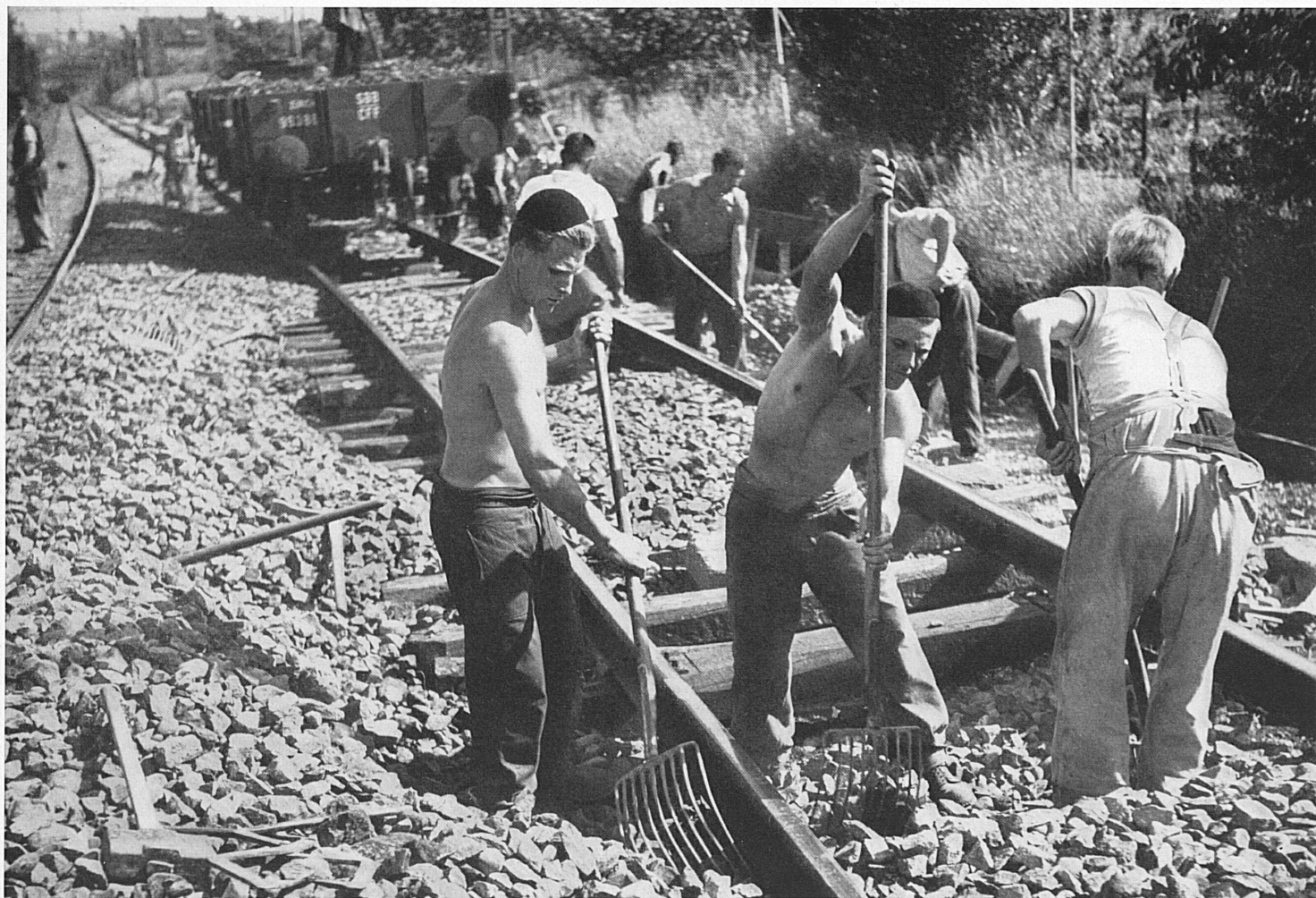
«Cramper» c'est, en langage technique, tasser le balast sous les rails et les traverses.
