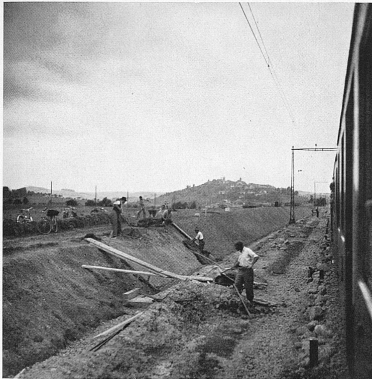
Ci-dessus: Entre Romont, dont la silhouette se dessine à l'arrière-plan, et Villaz-St-Pierre, on travaille actuellement au terrassement de la seconde voie. Ce parcours presque rectiligne de 5 km. ne soulève aucune difficulté technique. — Oben: Zwischen Romont, dessen Silhouette im Hintergrund sichtbar wird, und Villaz-St-Pierre wird gegenwärtig am Unterbau des zweiten Geleises gearbeitet. Auf der 5 km langen, fast völlig geraden Strecke stellen sich keine technischen Schwierigkeiten ein.
