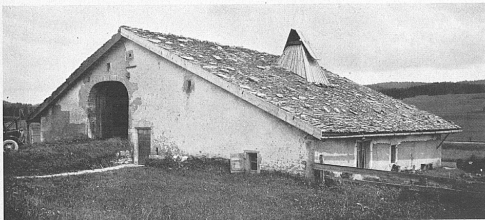
Unten: Jurassisches Haus mit Deckelkamin im Neuenburger Hochjura. — Ci-dessous: Cheminée à couvercle dans le Haut-Jura neuchâtelois.
