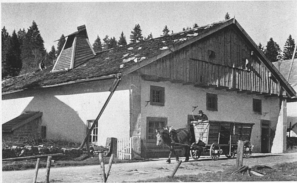
Oben: Jura-Haus mit Deckelkamin in La Corbatière (Neuchâtel). — Ci-dessus: A la Corbatière (Neuchâtel), maison jurassienne avec cheminée à couvercle. Photo: Maurer.
