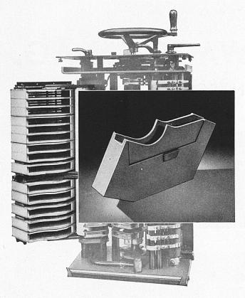
Funkenkammern aus Pyrostea für Schaltgeräte
