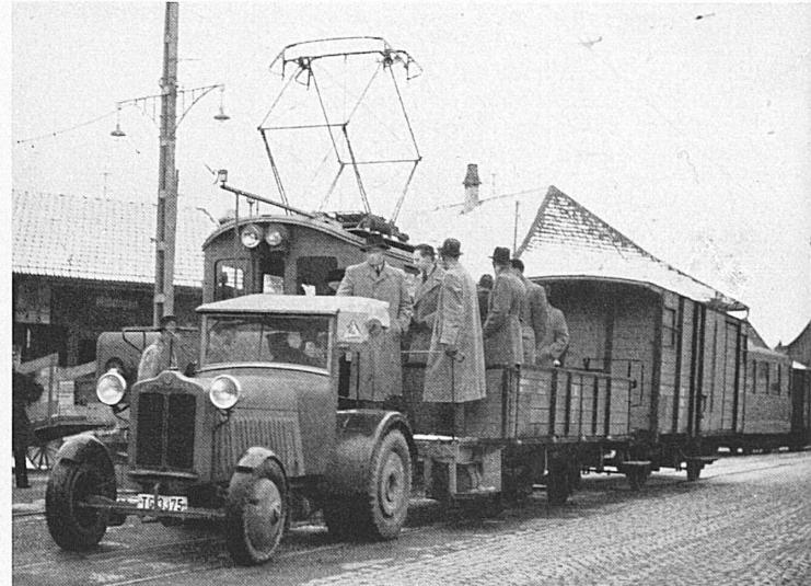
*Zur Bedienung des Güterverkehrs zwischen der Station Matzingen der Frauenfeld-Wil-Bahn und der nahegelegenen Mühle steht seit 1935 als überaus rationelle Lösung ein Benzintraktor zur Verfügung, der vor die Güterwagen gekuppelt wird. — Pour faciliter le service du trafic des marchandises entre la station de Matzingen, sur la ligne Frauenfeld-Wil, et le moulin situé dans le voisinage, on a mis à disposition, depuis 1935, un tracteur à benzine relié aux wagons de marchandises.*
