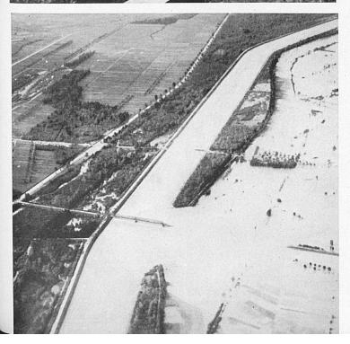
Links, von oben nach unten: Blick vom Calanda gegen den nach Osten (links) geneigten Heinzenberg (Bildmitte) und das Einzugsgebiet der Nolla dahinter. — Die furchtbaren Erosionstrichter der Nolla am Piz Beverin. — Der durch ein Hochwasser, primär aber durch die stete Schuttzufuhr und Außschüttung verursachte Durchbruch des Rheindamms bei Schaan am 26. September 1927.
