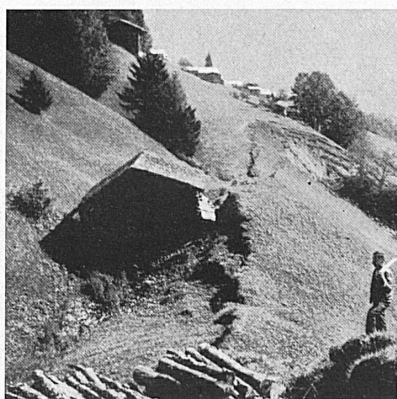
Oben, von links nach rechts: Straße im Sertigtal, die immer wieder durch eine Rufe unterbrochen wird. — Dieser Stall in einer Sackungspalte bei Schuders wurde schon viermal wieder aufgerichtet und ist heute unbenutzbar.
