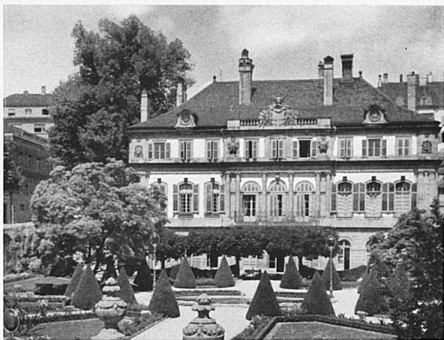
La façade de l'Hôtel du Peyrou à Neuchâtel. C'est une réussite exquise que cette grande façade, avec ses corniches, ses sculptures et le groupement de ses colonnes et de ses pilastres; il y a là un art de la composition d'une sûreté et d'une élégance parfaites. C'est dans ce somptueux palais que s'est tenue, récemment, la Conférence diplomatique internationale de Neuchâtel.
