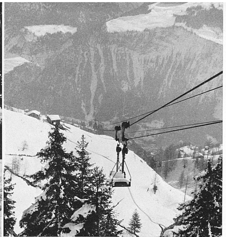
Oben, von links nach rechts: Der winterliche Aletschgletscher; nahe seinem unteren Ende befindet sich der Stolleneingang der neuen Bisse. — Die Luftseilbahn zwischen Mörel (780 m) und dem Stollen (1440 m) zur Versorgung des Bauplatzes mit dem nötigen Material. — En haut, de gauche à droite: Le glacier d'Aletsch en hiver; à son extrémité se trouve l'entrée de la galerie par laquelle passe le nouveau bisse. — Le téléferique reliant Mörel (780 m.) et la galerie (1440 m.), et qui amène au chantier le matériel nécessaire.
