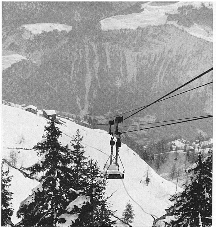
Oben, von links nach rechts: Der winterliche Aletschgletscher; nahe seinem unteren Ende befindet sich der Stolleneingang der neuen Bisse. — Die Luftseilbahn zwischen Mörel (780 m) und dem Stollen (1440 m) zur Versorgung des Bauplatzes mit dem nötigen Material. — En haut, de gauche à droite: Le glacier d'Aletsch en hiver; à son extrémité se trouve l'entrée de la galerie par laquelle passe le nouveau bisse. — Le téléphérique reliant Mörel (780 m.) et la galerie (1440 m.), et qui amène au chantier le matériel nécessaire.
