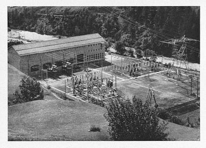
Zentrale in Airolo mit Freiluft-Schaltanlage. Rechts Gittermast der Gotthardleitung, die die Verbindung der Tessiner Wasscrkräfte mit der Nordschweiz vermittelt. — Centrale à Airolo avec transformateurs en plein air. A droite, pylone de la conduite du Gothard, qui relie les forces du Tessin à celles de la Suisse septentrionale.
