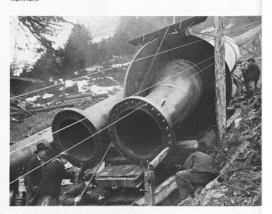
Ein interessantes Teilstück der Druckleitung: Dus wuchtige Hosenrohr für die Verzweigung des Druckschachtes in zwei freiliegende Rohrstränge. — Partie intéressante de la conduite forcée.
