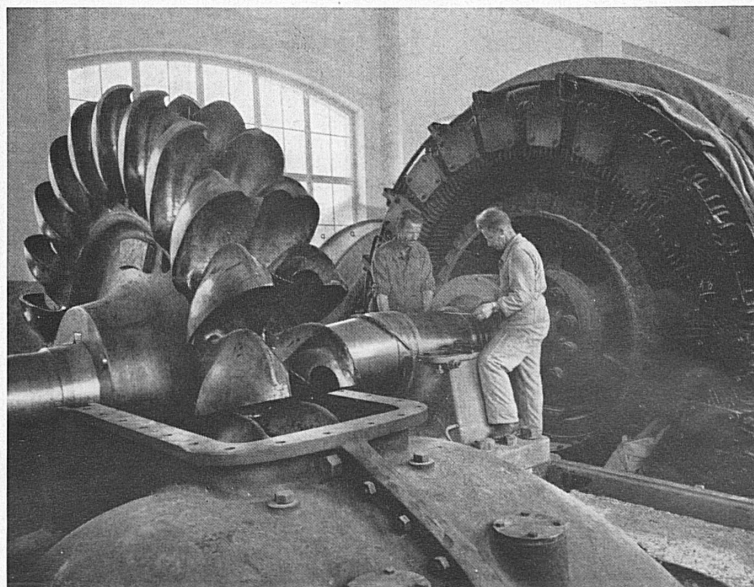
Montage einer Maschinengruppe in der Zentrale Airolo; vorn das gewaltige Schaufelrad einer Turbine von 33 000 PS. — Montage d'un groupe de machines dans la centrale d'Airolo; en avant, une énorme roue à pelles d'une turbine de 33.000 CV.
