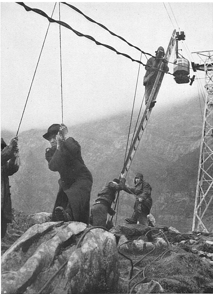
Tagelanger Arbeit bedarf es, um die beiden Seile auszuwechseln, während die mit einem Mann besetzten Kabinen oft stundenlang stillstehen, bis irgendeine kritische Phase des schwierigen Werkes überwunden ist.*
