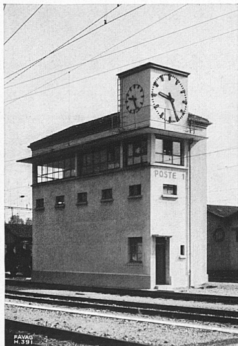
Horloges électriques d'un poste d'aiguillage
