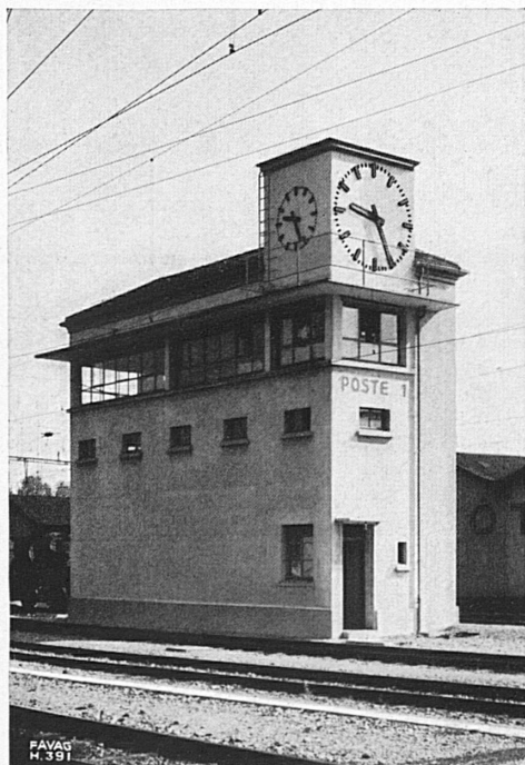
Horloges électriques d'un poste d'aiguillage
