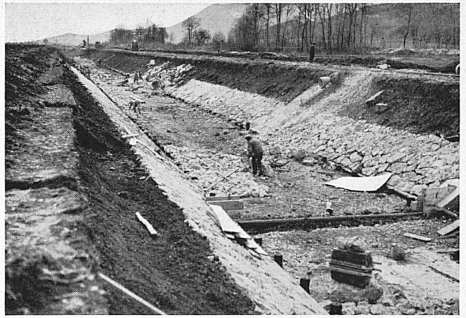
Konsolidierung des Kanals zwischen Oberbuchsiten und Oensingen. Consolidation du canal entre Oberbuchsiten et Oensingen.
