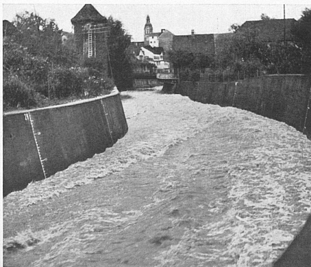
Neuer Kanal mit Blick gegen die Lebernbrücke in Olten. Vue du nouveau canal vers la Lebernbrücke à Olten.
