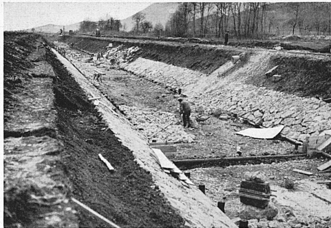
Konsolidierung des Kanals zwischen Oberbuchsiten und Oensingen. Consolidation du canal entre Oberbuchsiten et Oensingen.
