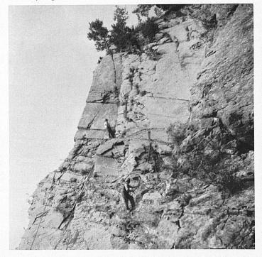
Rechts: Zum Sprengen des Gesteins werden beim Vortrieb Löcher von 1-1,5 m Länge gebohrt, in denen der Sprengstoff zur Explosion gebracht wird. Rechts außen: Bei Sisikon erfolgt die Mauerung des neuen Tunnelgewölbes ein kurzes Stück weit im Freien. — A droite: On creuse des trous de 1 à 1,5 m. de long pour y placer l'explosif qui fera sauter la roche. -- Adroite. en dehors: Construction, près de Sisikon, de la voûte du nouveau tunnel.
